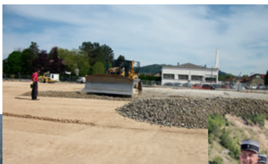
PRÉPARATION DE LA PLATEFORME ▼ ▶
